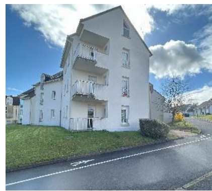
Chemin de marche sécurisé
